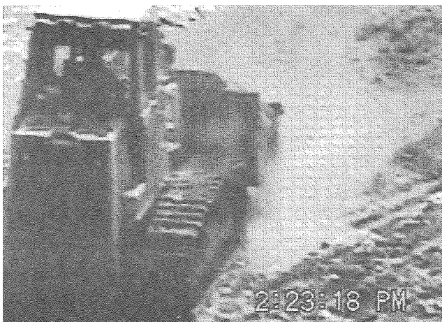
敷きならしの際の灰の飛散状況
